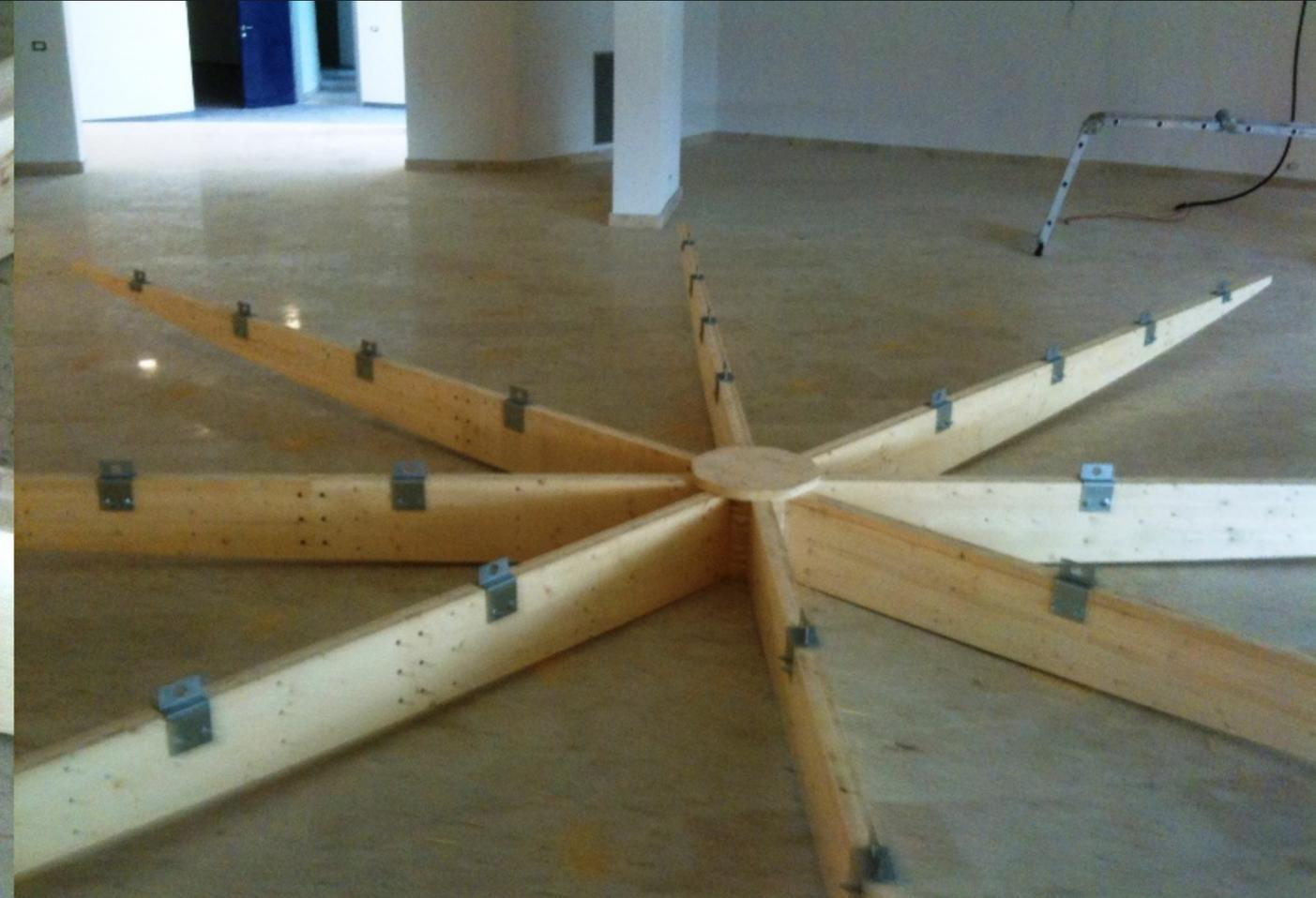
Costruzione a terra del telaio in legno
