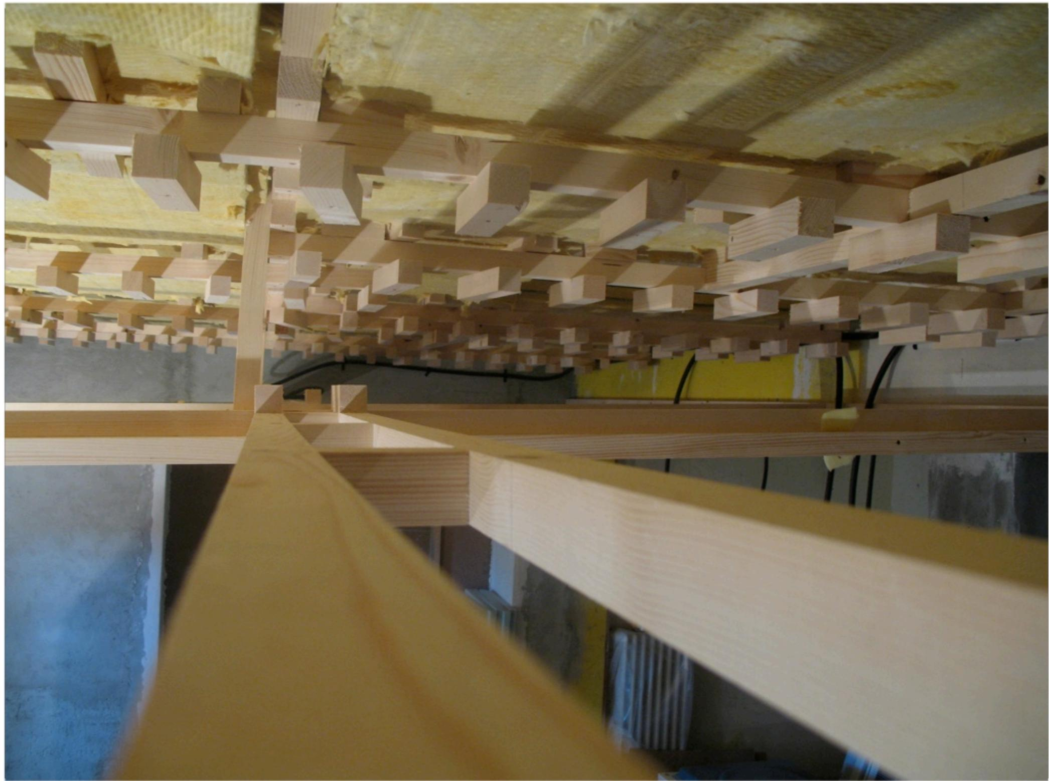
**Step I: lana ad alta densità con 1 mm di piombo per isolamento acustico verso il piano superiore.**
