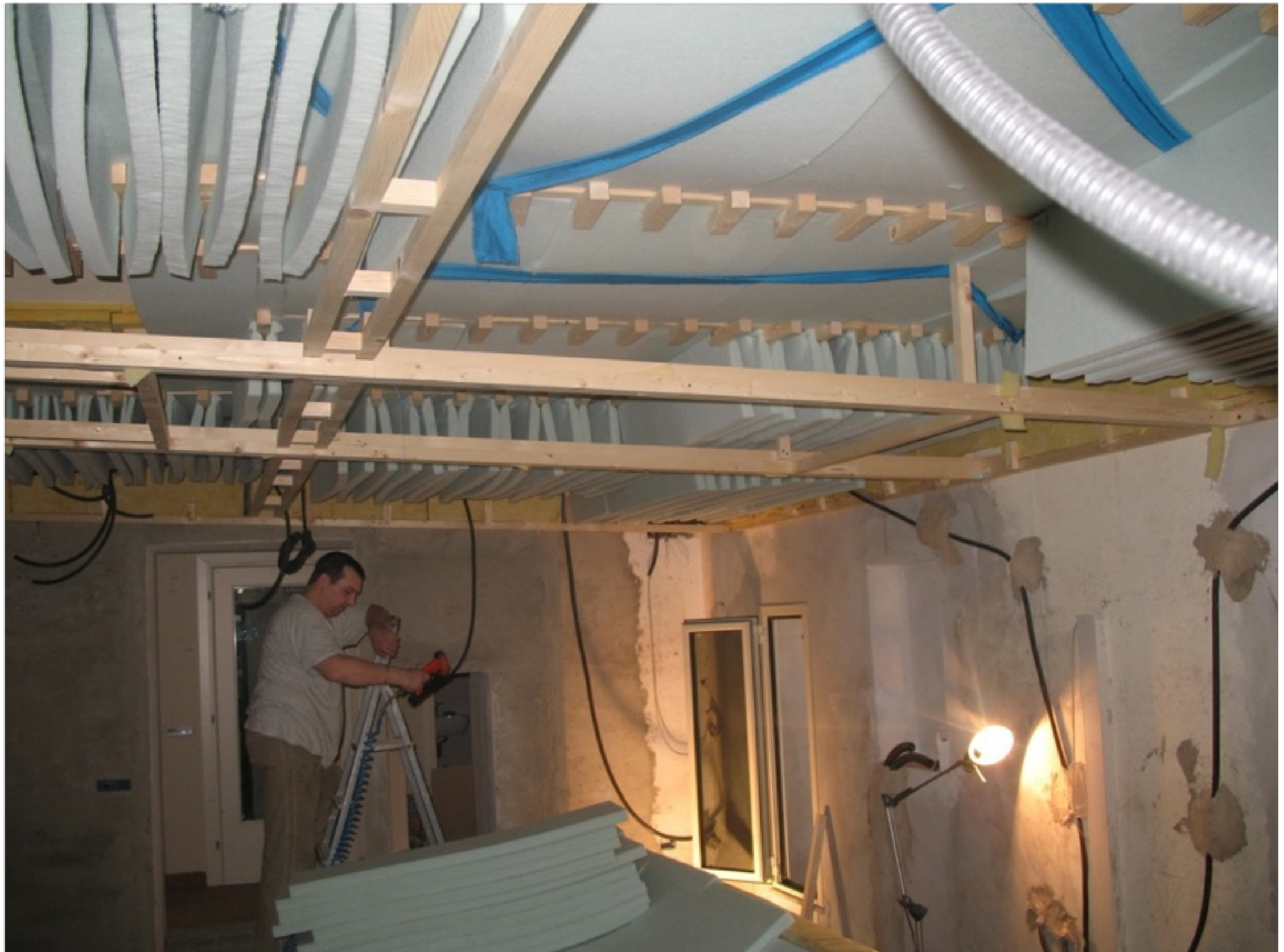
Step 3: fibra di poliestere appesa in verticale.
