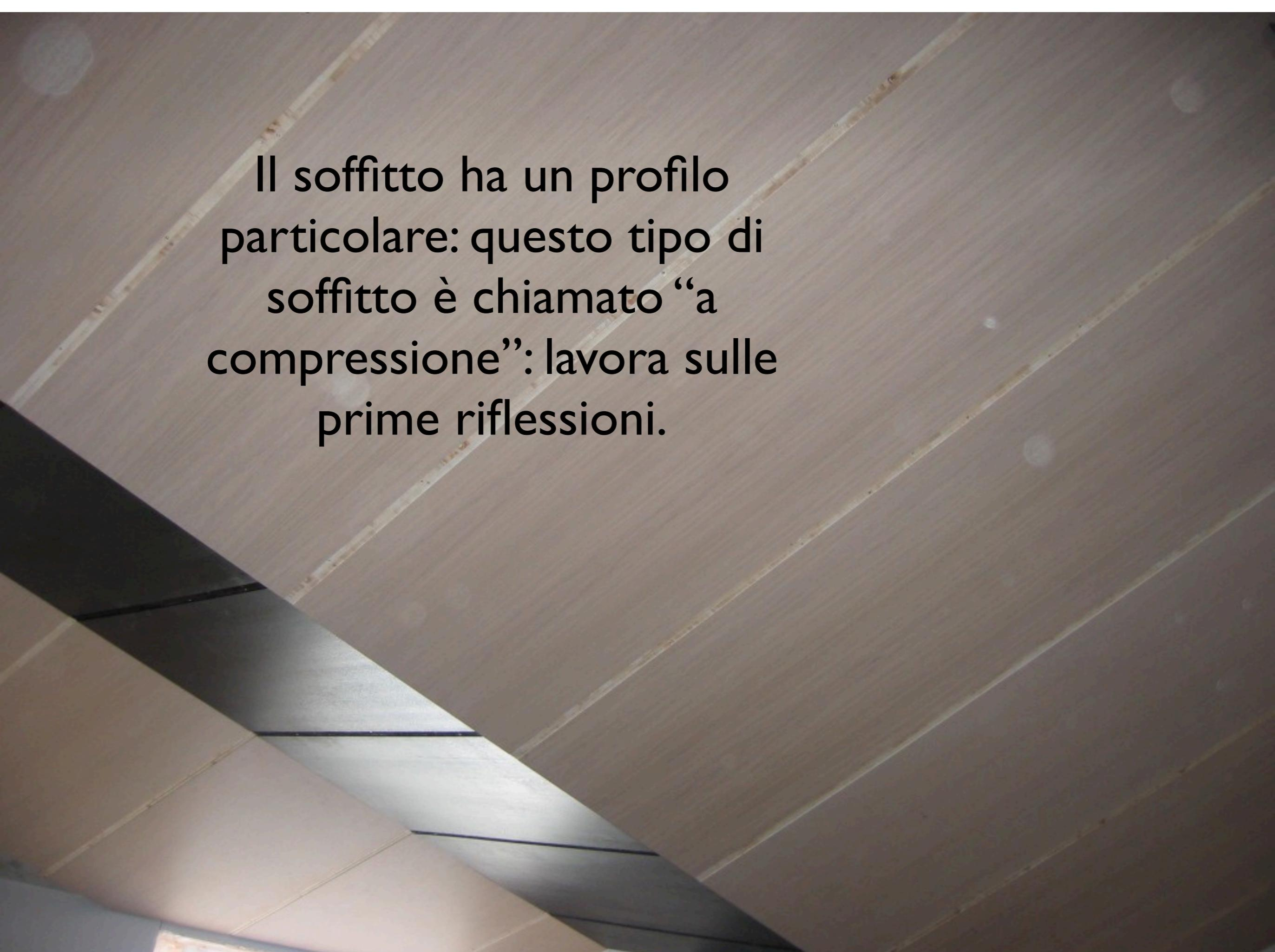
Il soffitto ha un profilo particolare: questo tipo di soffitto è chiamato “a compressione”: lavora sulle prime riflessioni.
