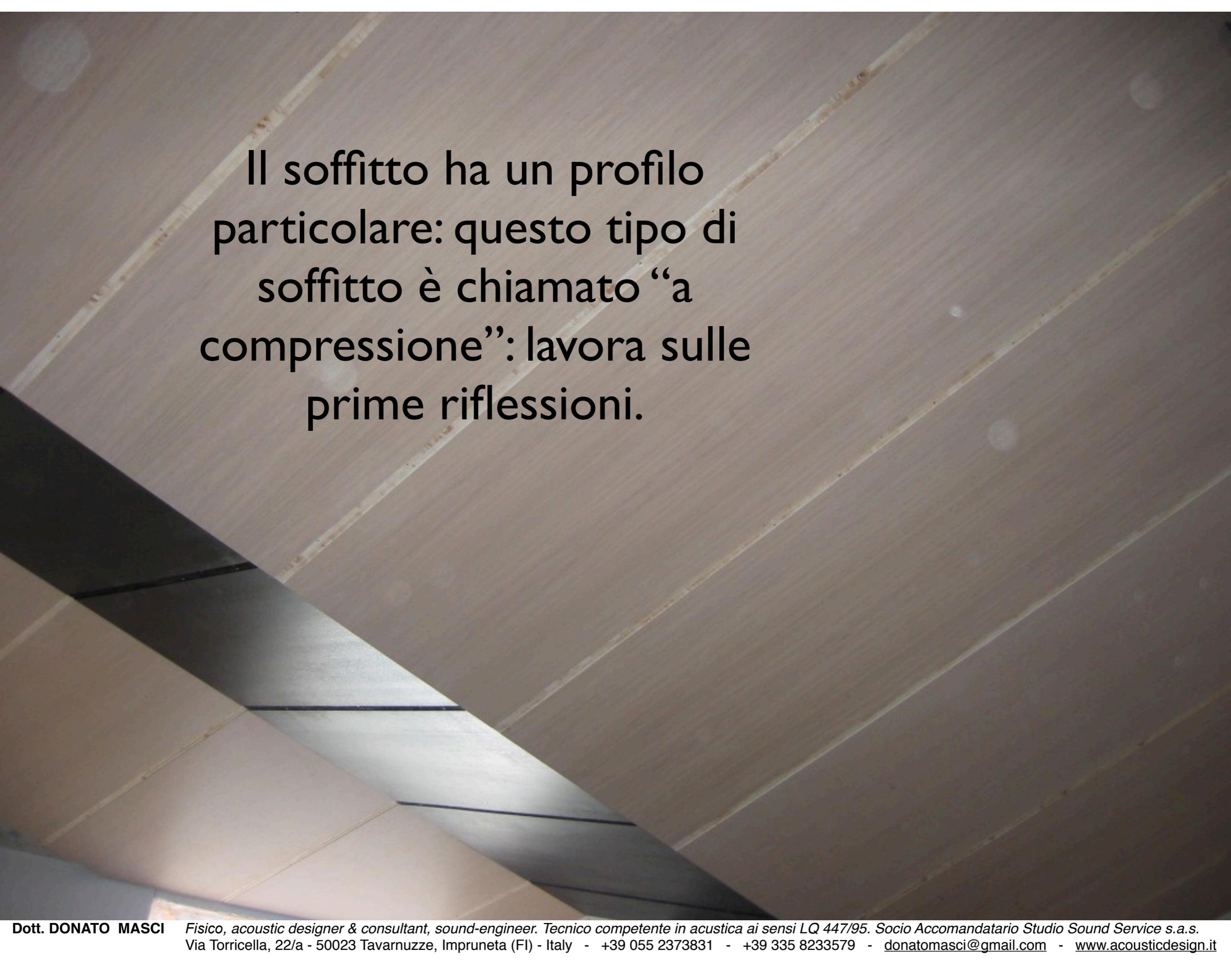
Il soffitto ha un profilo particolare: questo tipo di soffitto è chiamato “a compressione”: lavora sulle prime riflessioni.
