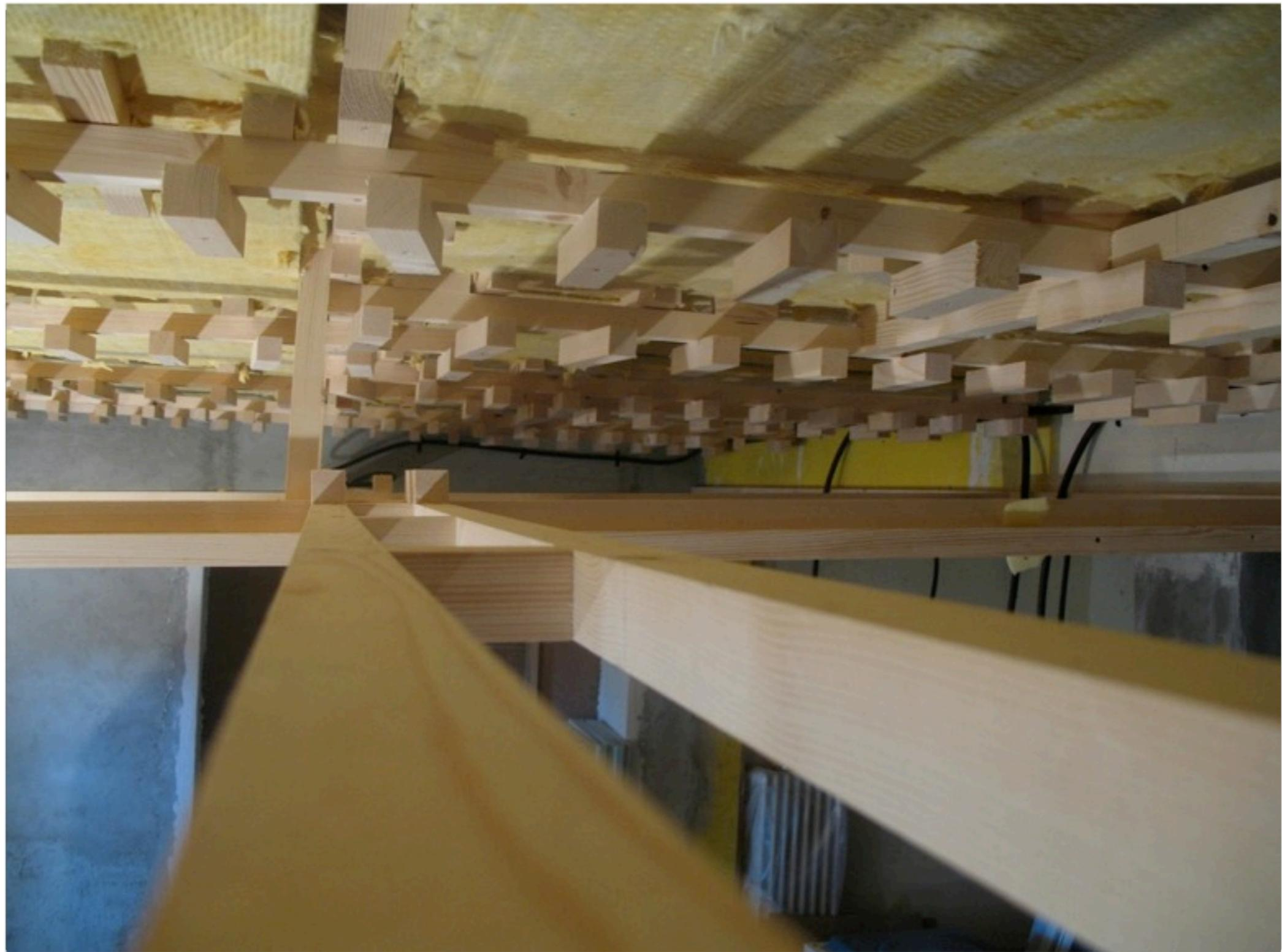
Step 1: lana ad alta densità con 1 mm di piombo per isolamento acustico verso il piano superiore.
