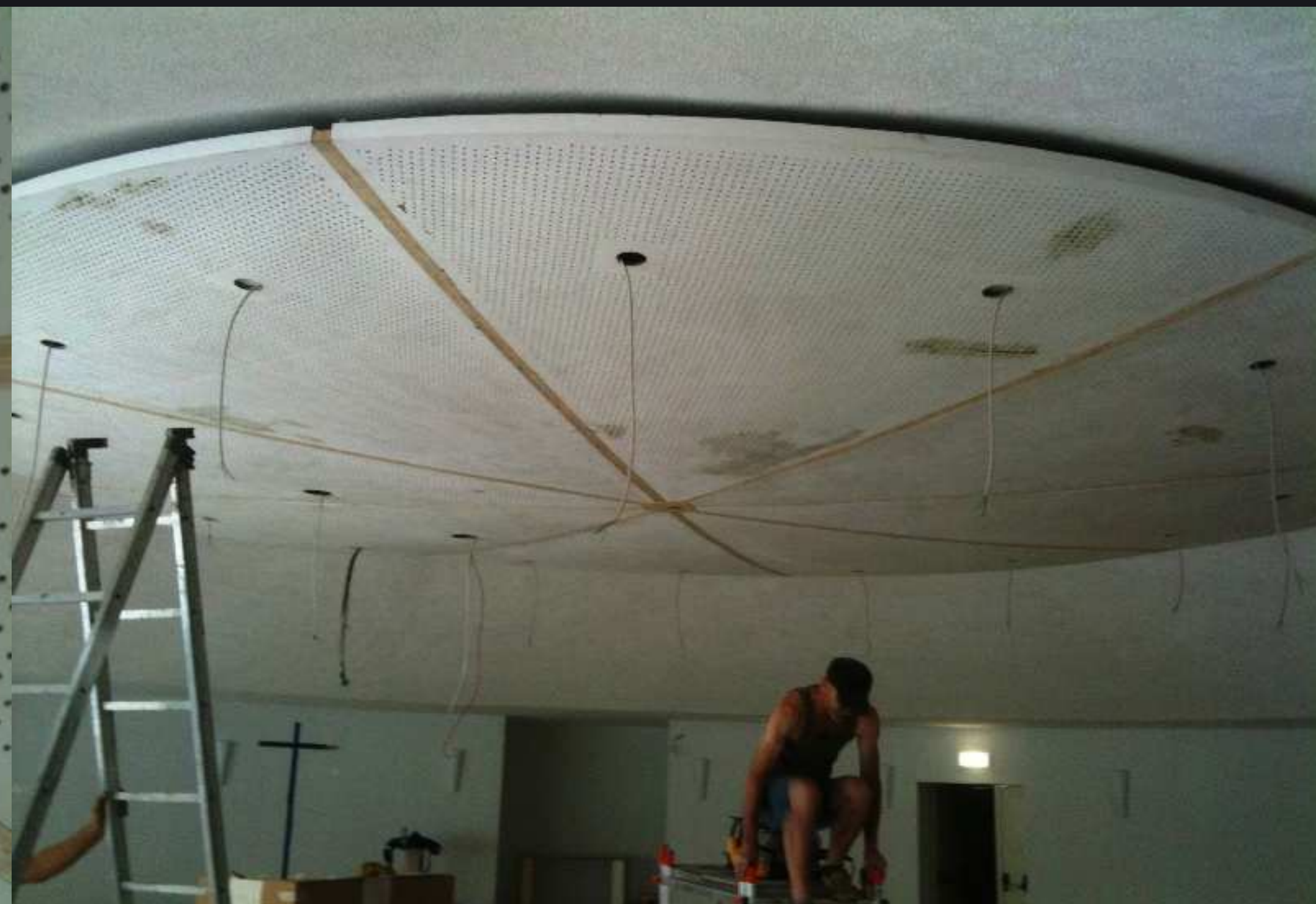
... ultimata la controcupola, mancano verniciatura e corpi illuminanti.
