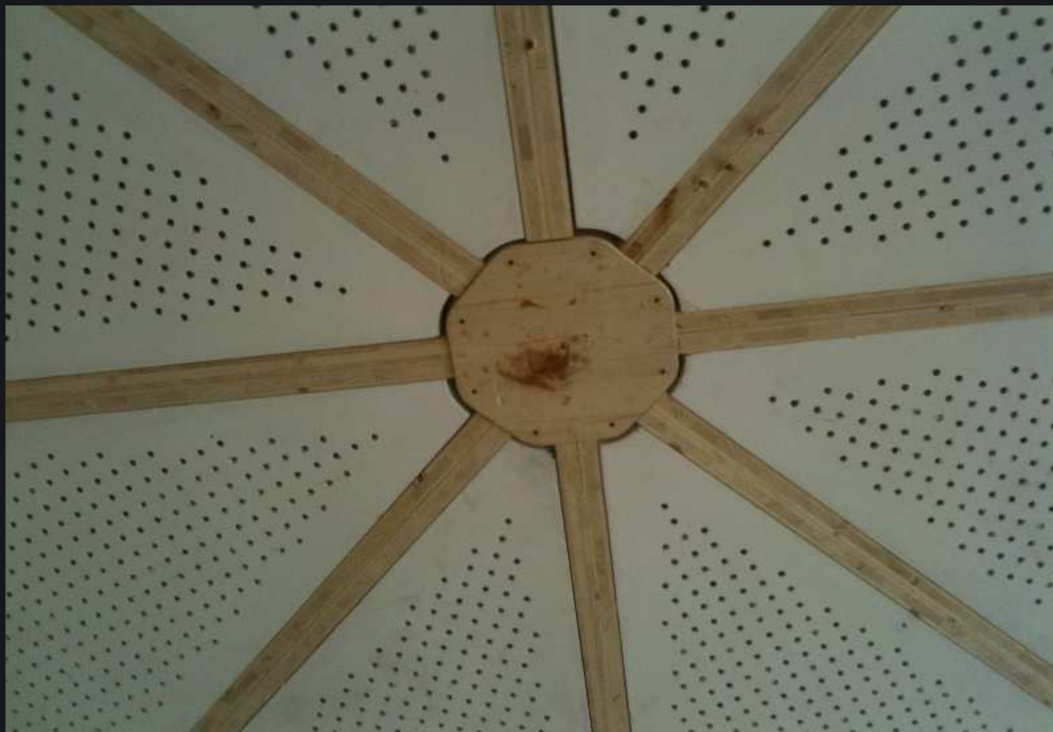
Applicazione delle lastre curvate e forate a pantografo
