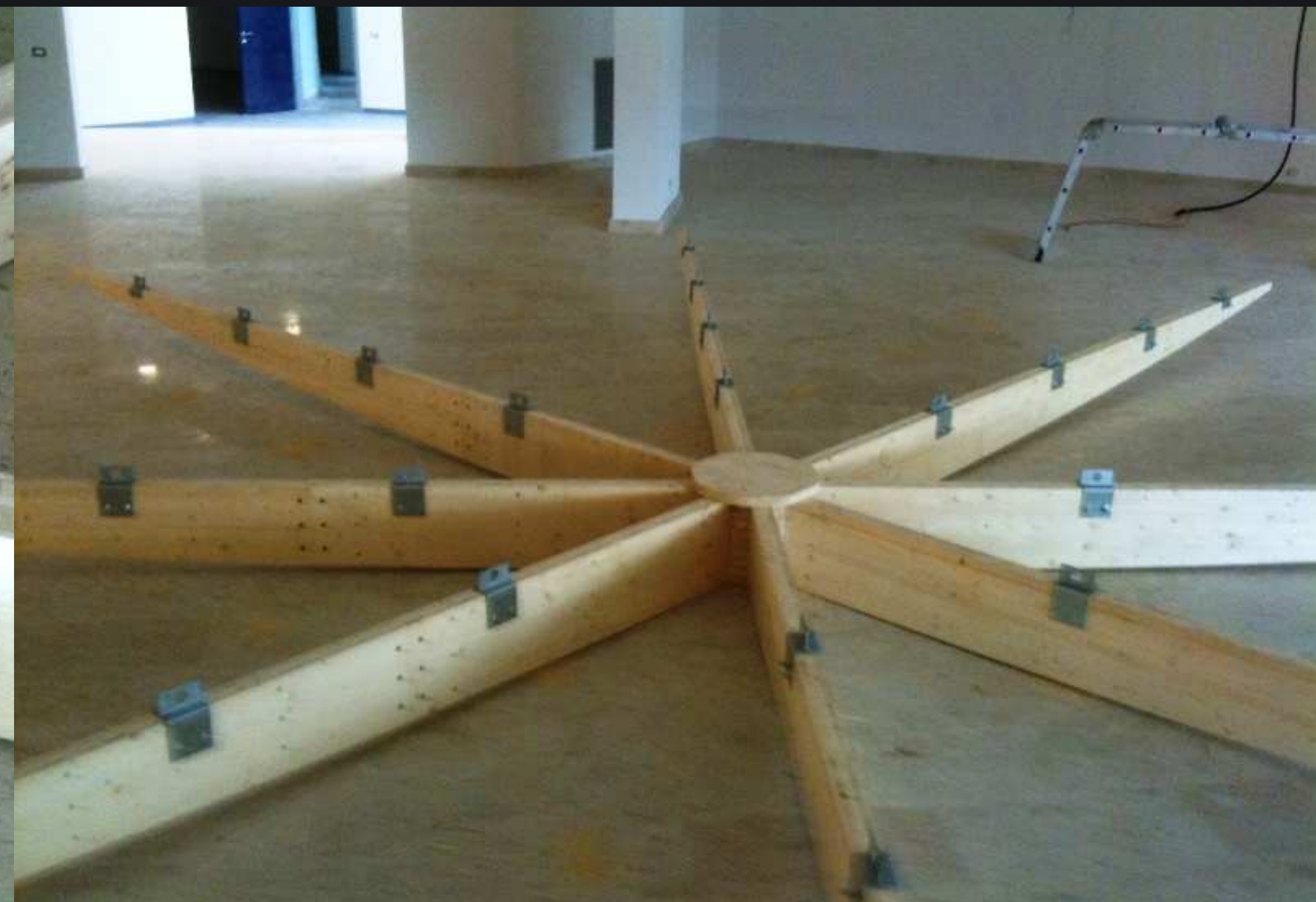
Costruzione a terra del telaio in legno lamellare
