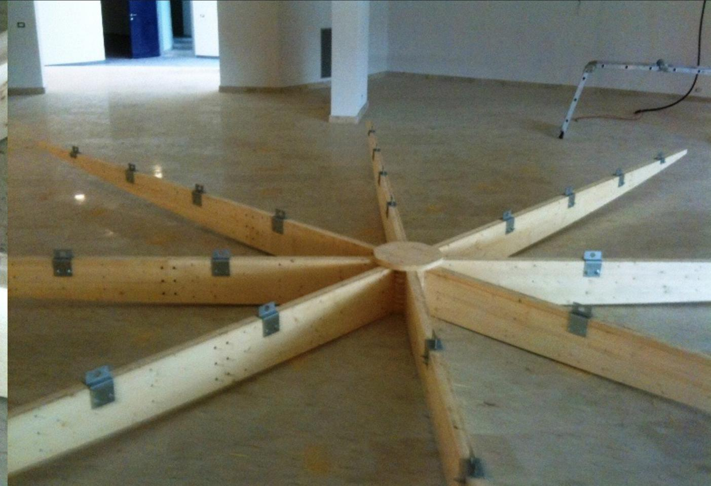
Costruzione a terra del telaio in legno
