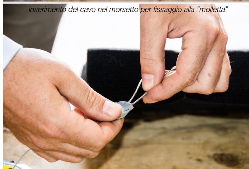
*inserimento del cavo nel morsetto per fissaggio alla "molletta"*
