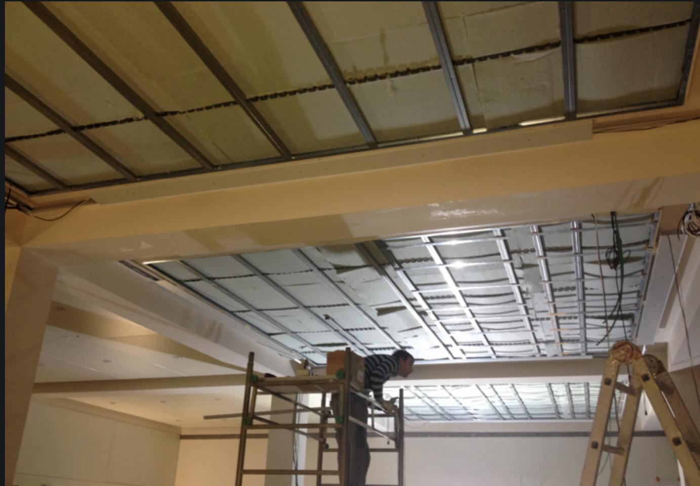
posizionamento materiale fonoassorbente e telaio per pannelli microforati
