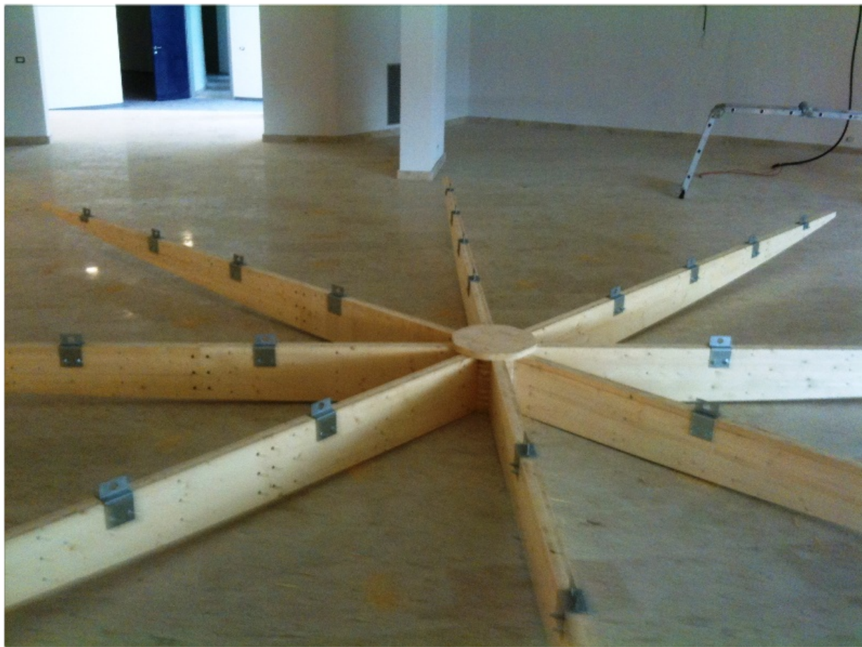
Costruzione a terra del telaio in legno lamellare
