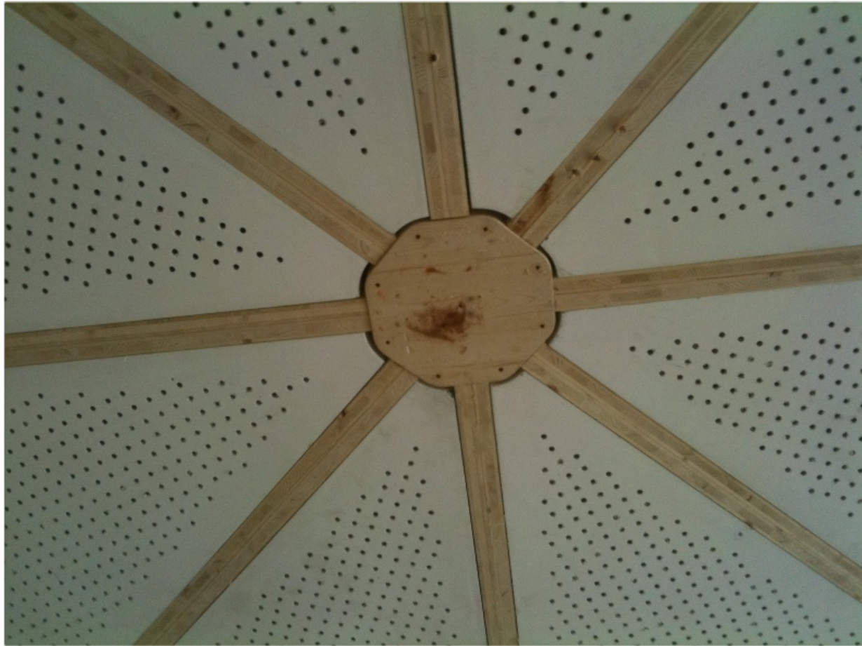
Applicazione delle lastre curvate e forate a pantografo
